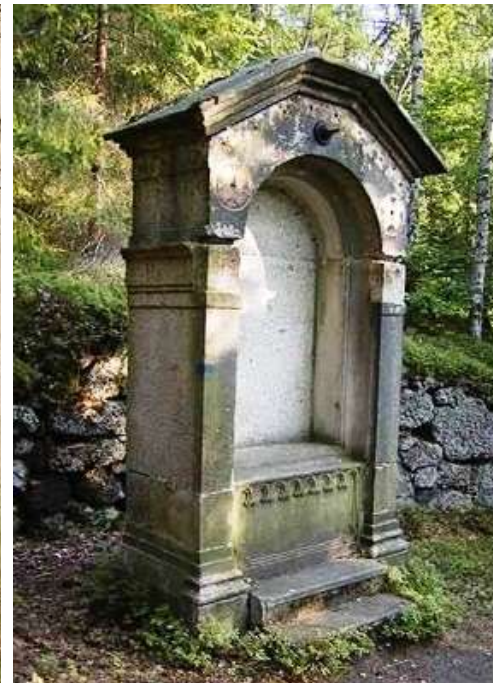
Eine der weniger beschädigten Kapellen vor der Renovierung
